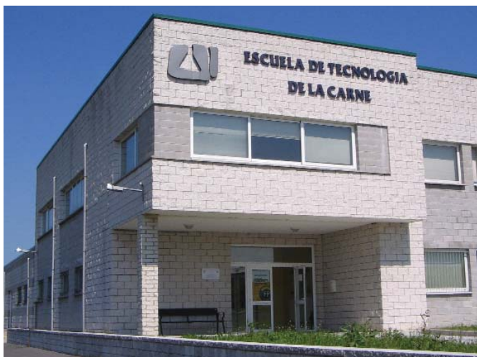
Instalaciones de ASINCAR
