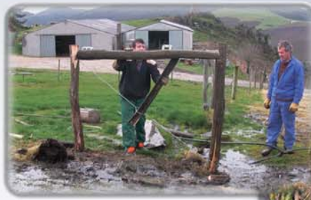
Construcción de cercas para el ganado
