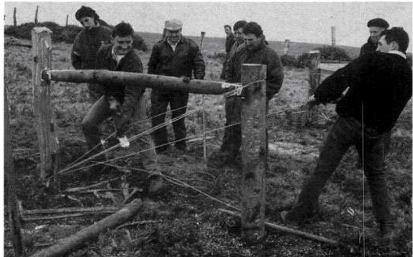
Instalación de una cerca de tensión para pastoreo. Detalle de apoyo principal.
